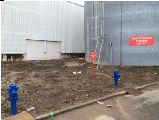
Réservoir aérien de 400 m 3 avec poteaux d'aspiration
