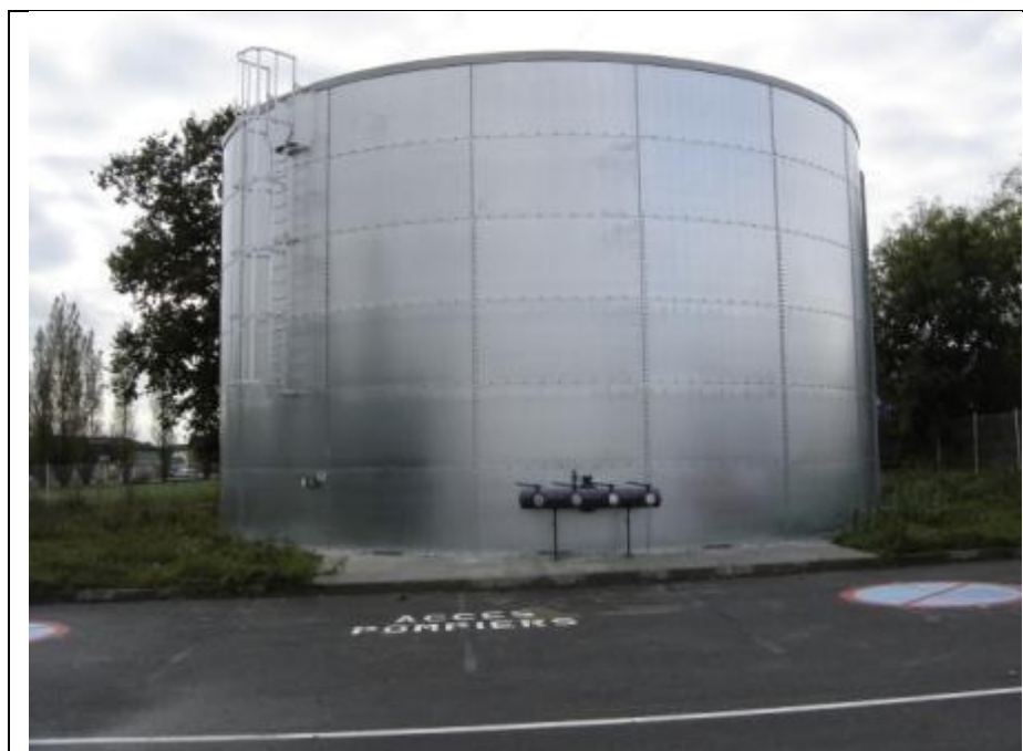
Réservoir aérien de 400 m 3 avec poteaux d'aspiration
