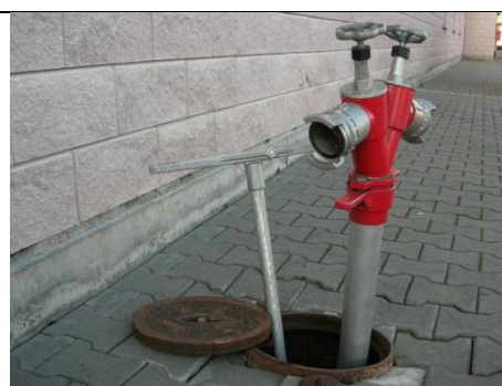
Colonne de prise d'eau montée sur hydrant de 80
