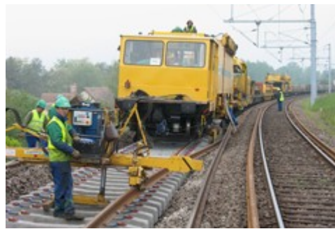
Longs Rails soudés sur traverses béton
