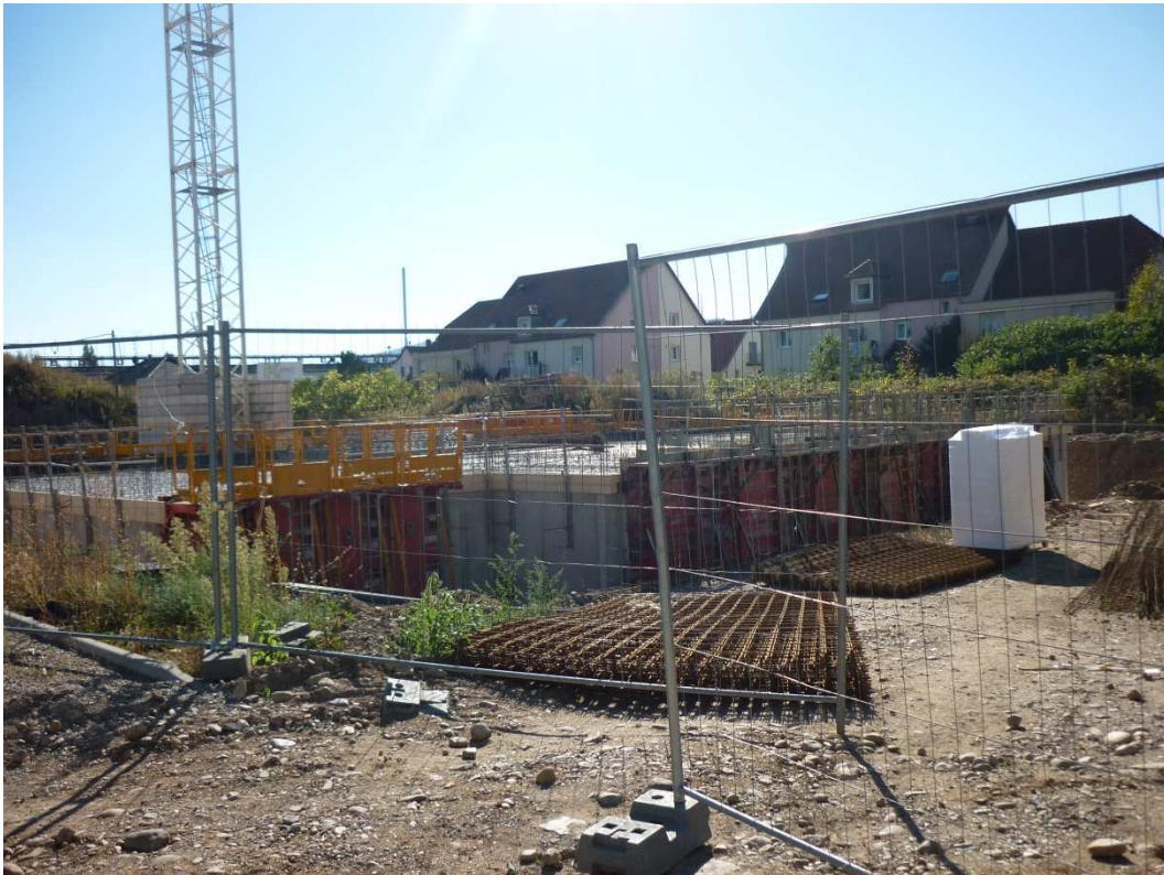
Chantier en cours domaine des Cépages – Quartier Saint-Vincent-de-Paul à Colmar
