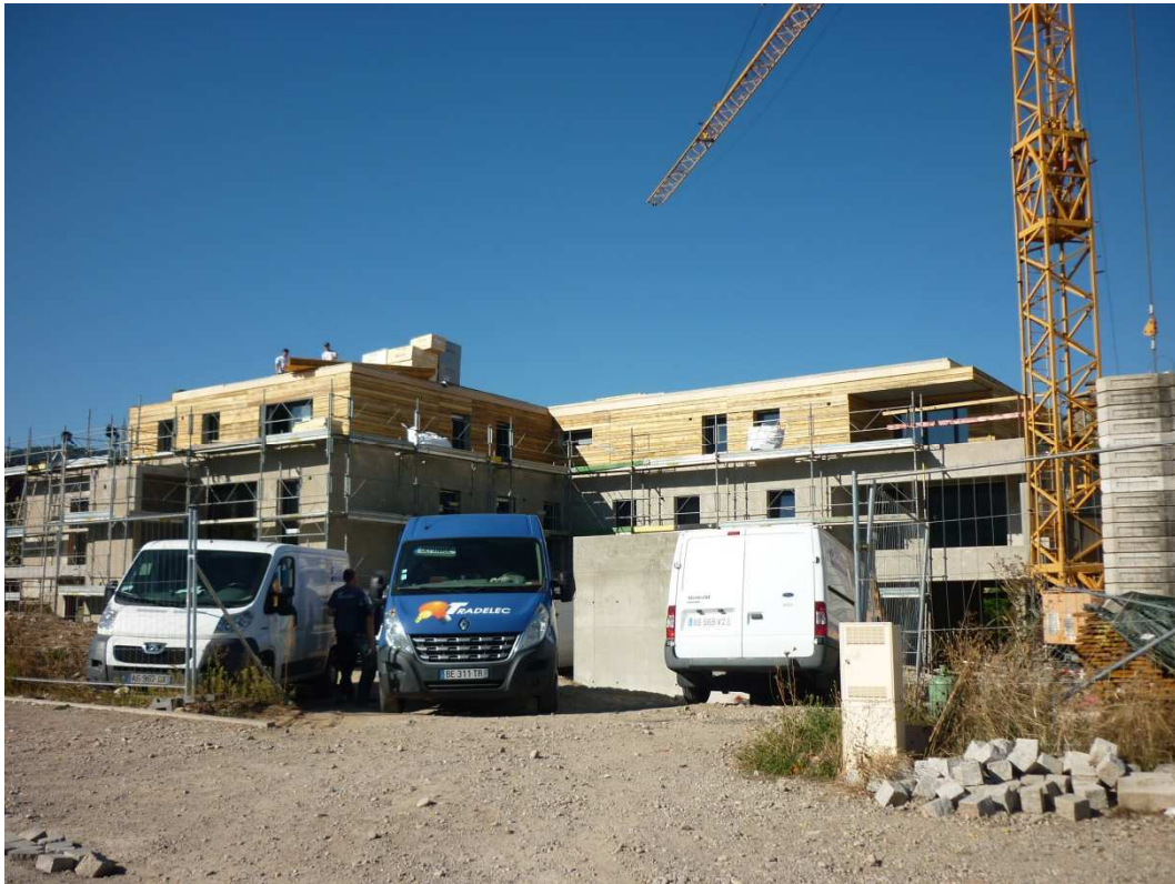
Villas Brand en chantier à Turckheim
