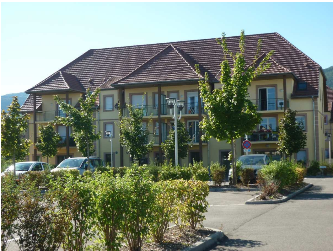
Résidence Service Senior Les Châteaux à Wettolsheim
