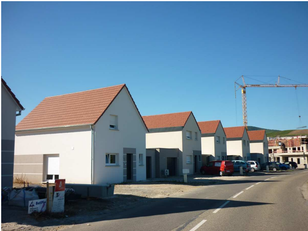
Maisons neuves accolées dans le quartier Brand à Turckheim
