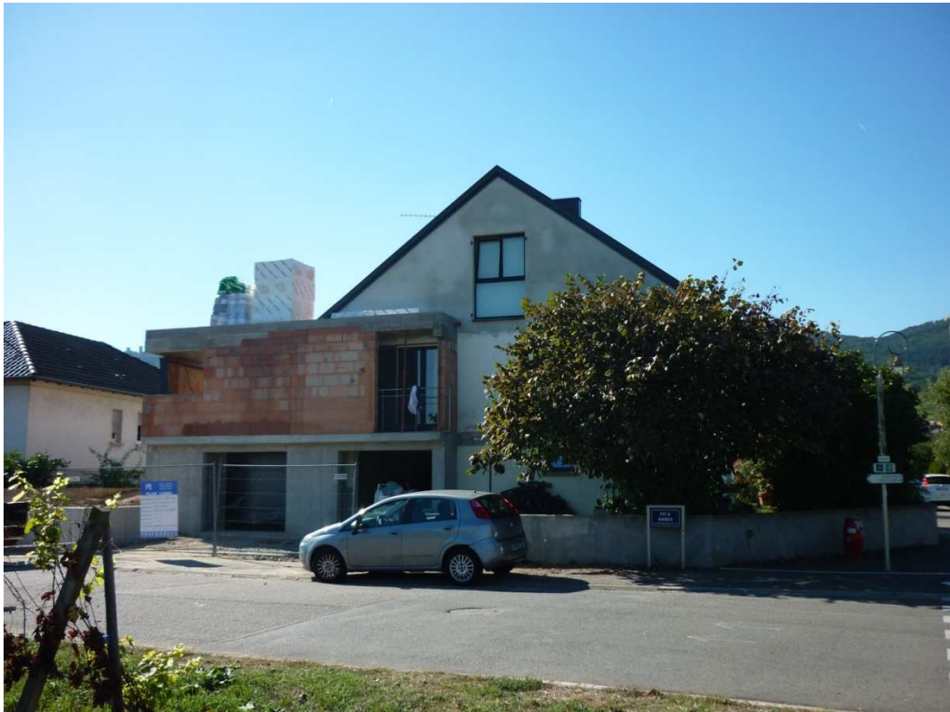
Travaux d'extension sur une maison individuelle à Wettolsheim
