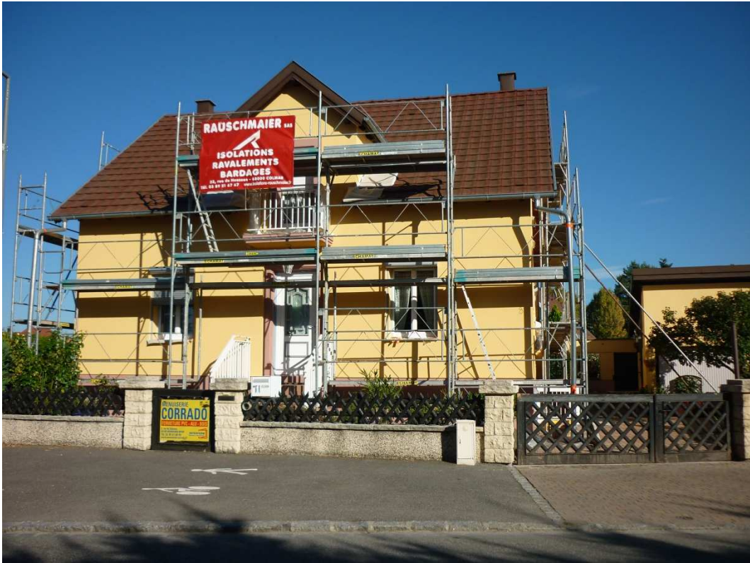
Travaux de rénovation à Andolsheim
