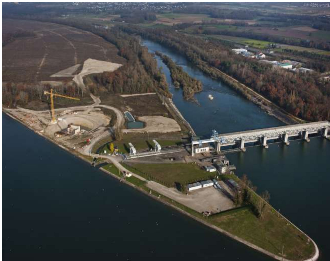
Lancement du chantier de la nouvelle centrale en 2011
