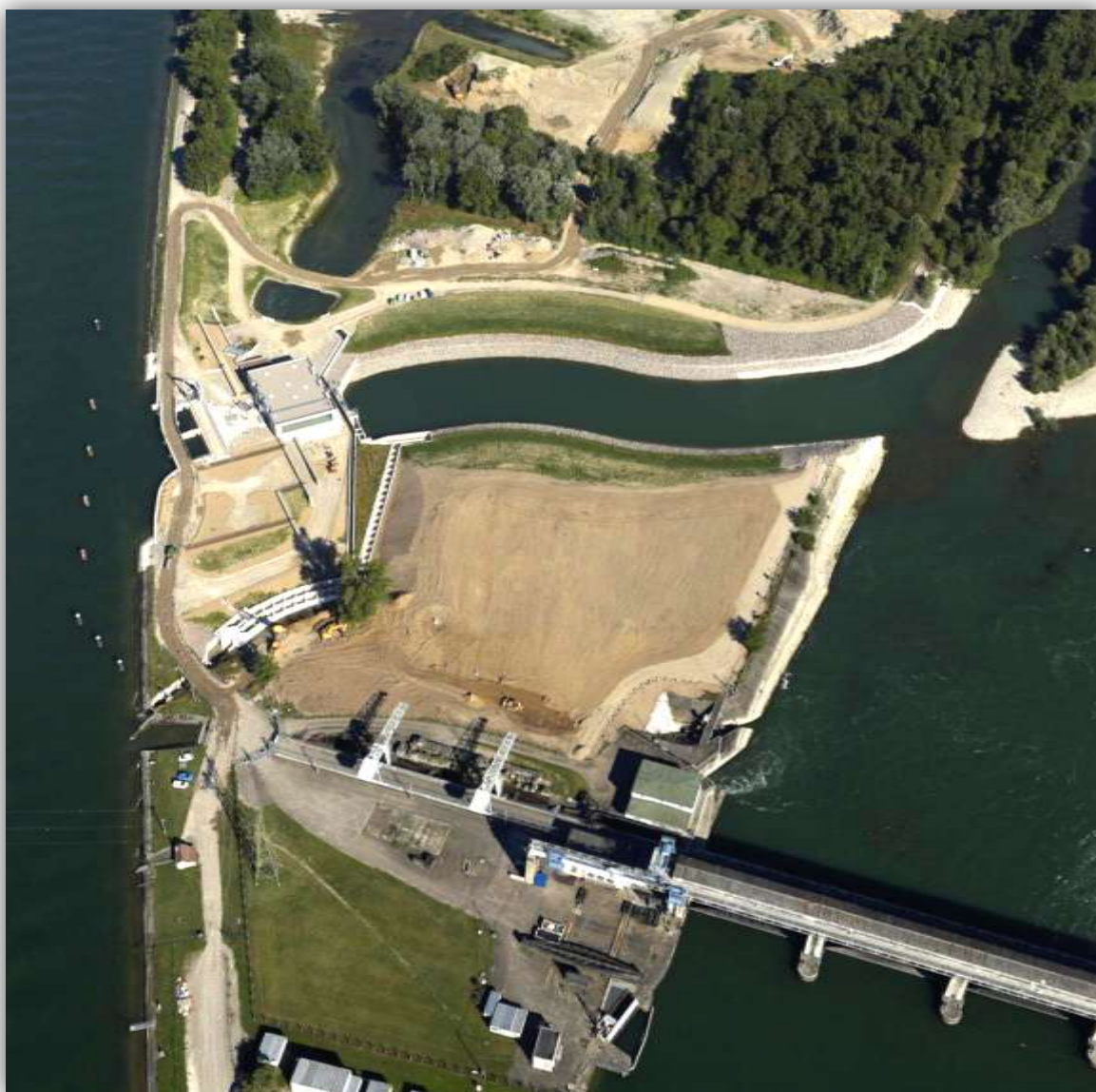
Le barrage et la centrale de Kembs vue du ciel – crédit photo : Laurent Rothan
