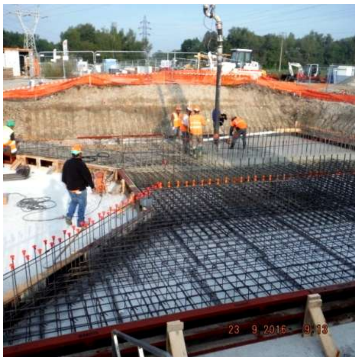
Travaux sur le site de la passe à poissons de Gerstheim (septembre 2016)
