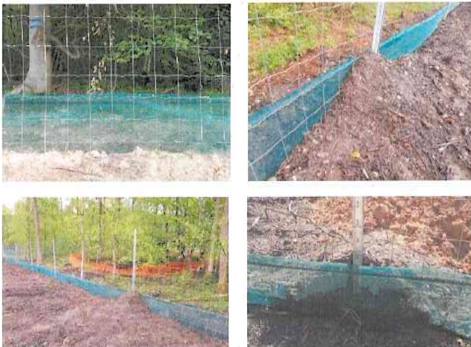
Figure 12: Exemple de dispositif anti-intrusions et semi-perméable © Biotope
